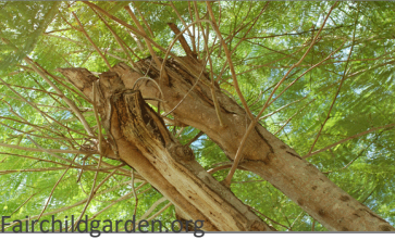
Ramas mal adheridas causadas por la poda de la copa del árbol.
